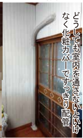
配管の露出部分を化粧カバーでキレイに
